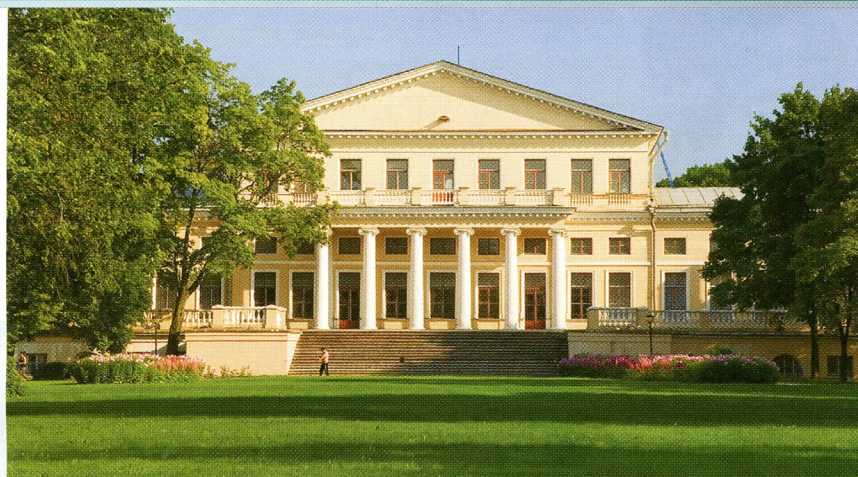
◀ Корпус Петербургского университета путей сообщения. Фасад, выходящий в Юсуповский сад.
